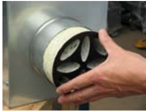
Druk de demper in de opening
